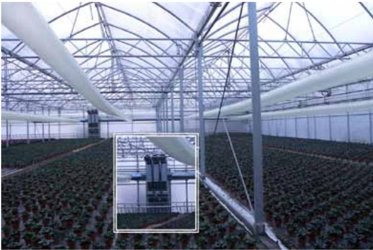
Figure 1 : La pompe à chaleur à déshumidification et les gaines de répartition de l'air sec dans la serre (culture d'hortensias).
